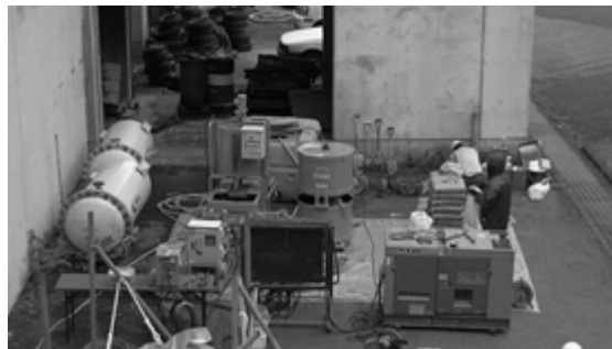
(a) 使用機器設備
